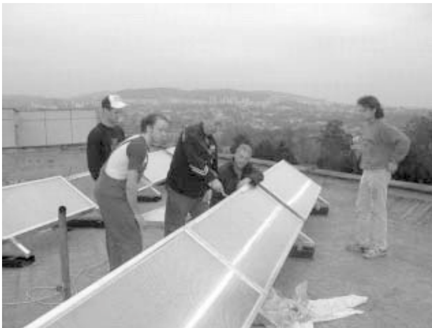
Montage einer Solarkollektoranlage in Usti nad Labem
